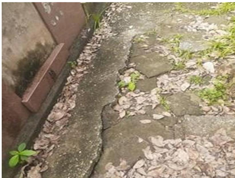
Figura 6. Rachaduras em uma das ruas do cemitério. Fonte: elaborado pelos autores.
